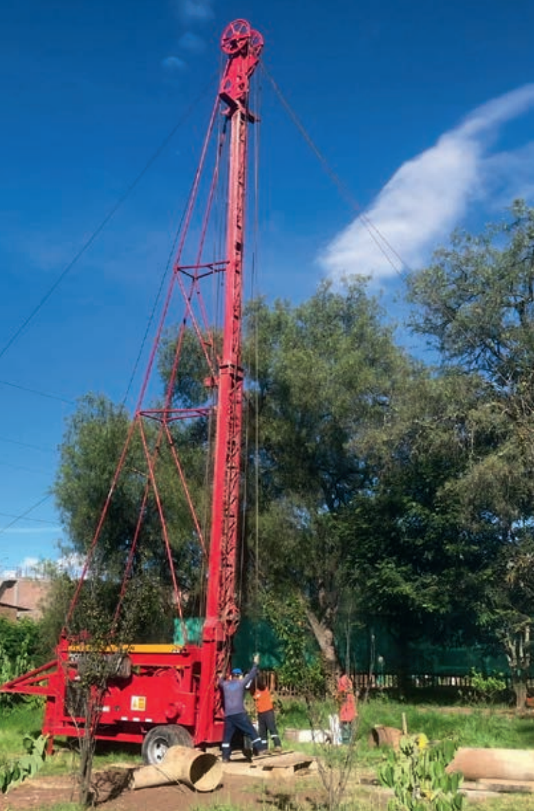
Wegen Felsgestein in 10 m Tiefe benötigen wir Spezialmaschinen.
